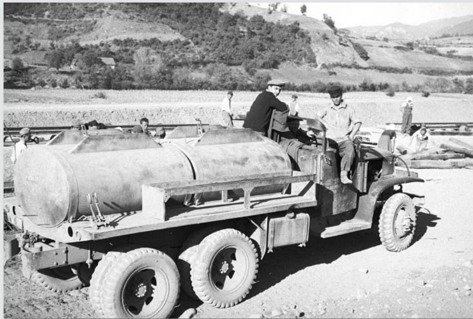
Аутомобил-цистерна за гориво ССКВ 353 из помоћи UNRRA током радова на железничкој пруги између Лашве и Какња 1947. године. На вратима „џемса“ види се латинична и ћирилична скраћеница ЈЖ и симбол омладинске пруге (Фолк-центар „Одбрана“)
